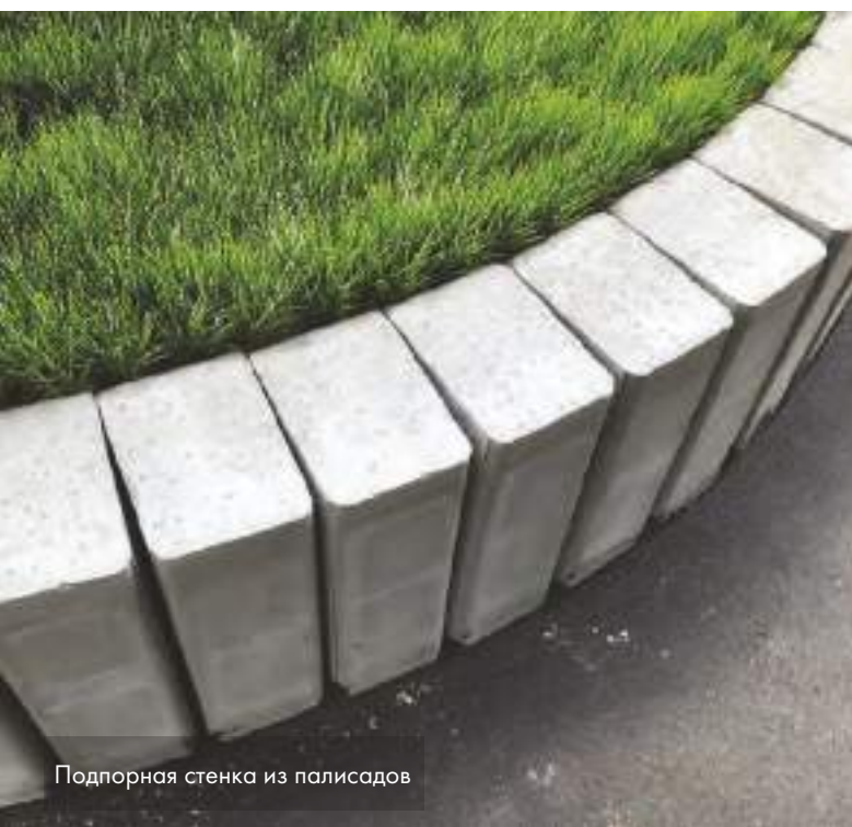
Подпорная стенка из блоков «Растефлор»
